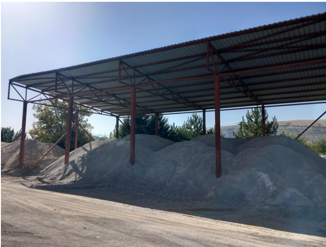
Слика 11. Покриено складиште за ризла-камен агрегат, поделен на повеќе бункери со вкупен капацитет за складирање камени фракции од 2700 t. Камените фракции се со димензии од 0-4, 4-8, 8-11, 8-16 и 16-22 mm.
