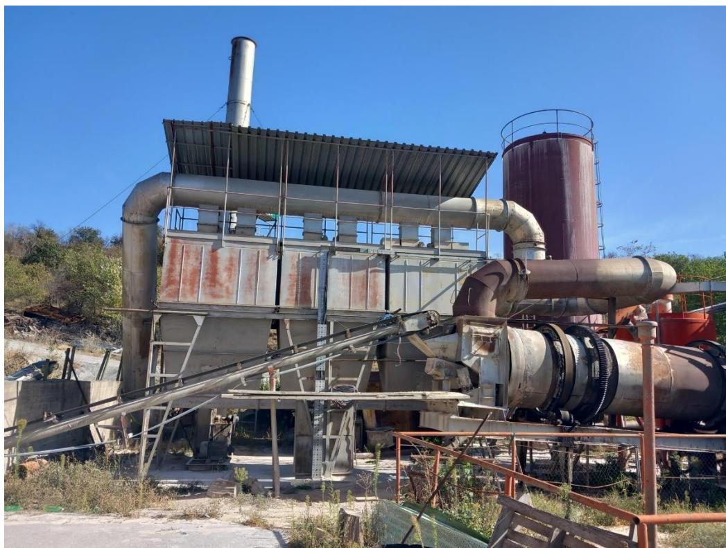
Слика 4. Асфалтна база – Подружница Велес при ЈП за одржување и заштита на магистралните и регионалните патишта – Скопје ц.о. Проектиран капацитет: 30 t/h.
