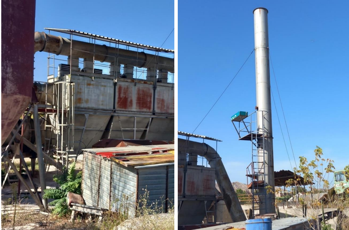
Слика II.8. Систем за отпашување на димните гасови од ротационата мешалка кој што се состои од циклон и комора за вреќести филтри (лево). Емитер (оџак) со висина од 14 и дијаметар од 0,8 m за одведување на димните гасови од ротационата сушара со пристапна платформа за поставување на мерна опрема за мерење на емисиите (десно).
