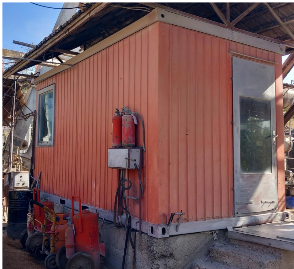
Слика XII.1. Противпожарни апарати во непосредна близина на технолошката постројка за производство на асфалт.
