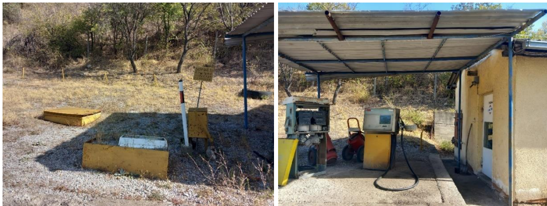
Слика 15. Подземен резервоар за складирање на гориво Еуроодизел БС и пумпа за точење
