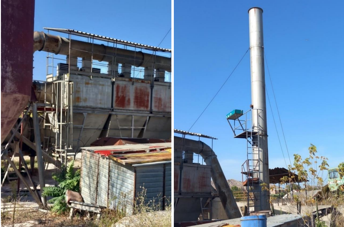
Слика 8. Систем за отпрашување на димните гасови од ротационата мешалка кој што се состои од циклон и комора за вреќести филтри (лево). Емитер (оџак) со висина од 14 и дијаметар од 0,8 m за одведување на димните гасови од ротационата сушара со пристапна платформа за поставување на мерна опрема за мерење на емисиите (десно).
