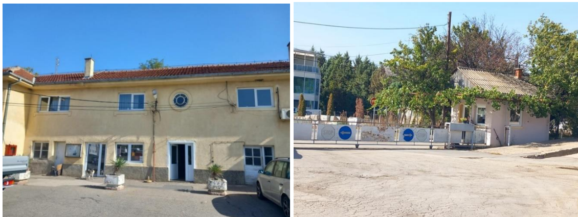
Слика II.3. Управна зграда и капија со портирница за влез на локацијата на асфалтната база – Подружница Велес при ЈП за одржување и заштита на магистралните и регионалните патишта – Скопје ц.о.
